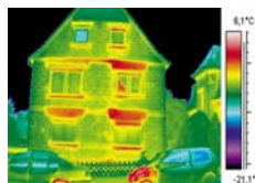
Dispersioni energetiche da finestre e porte verso l'esterno
